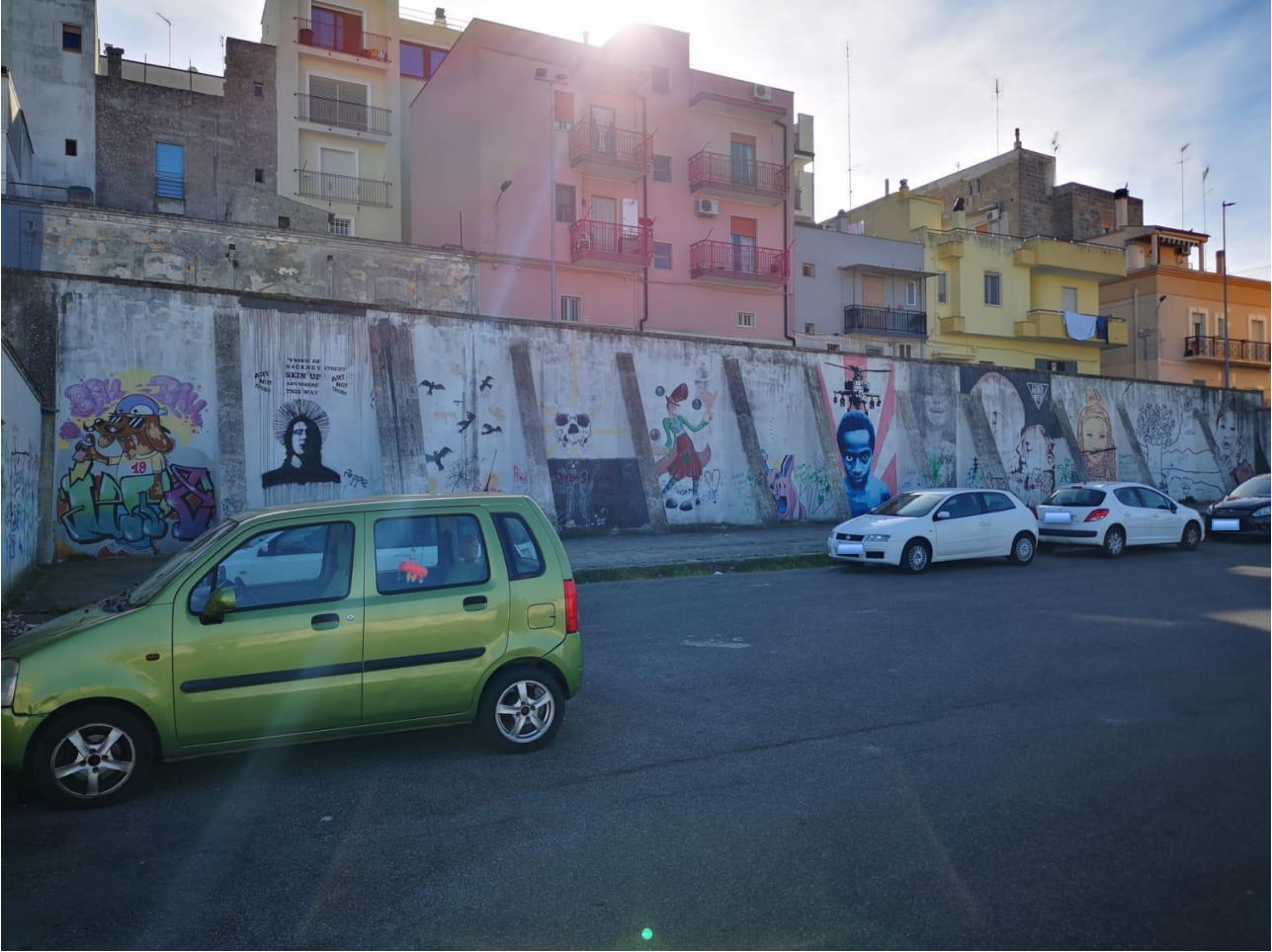
Foto della facciata oggetto d'intervento
